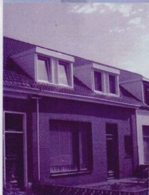
Voorbeeld van veel voorkomende kleine bouwwerken (dakkapel).
