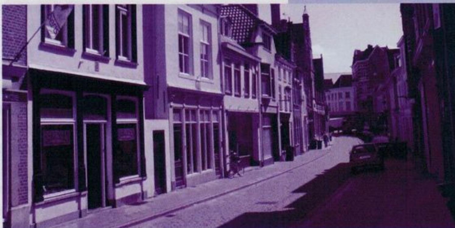
Beeld Steenbergsestraat na herinrichting. Uitgevoerd volgens uitgangspunten project Herinrichting Openbare Ruimte Binnenstad, typologie radiaal.
