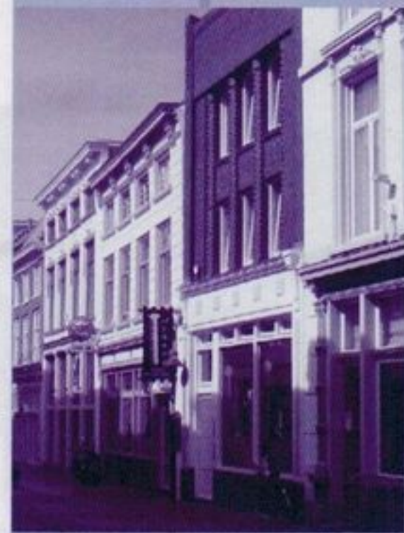
In de Fortuinstraat is een goed voorbeeld te vinden van twee panden met één functie (doorbraak).
