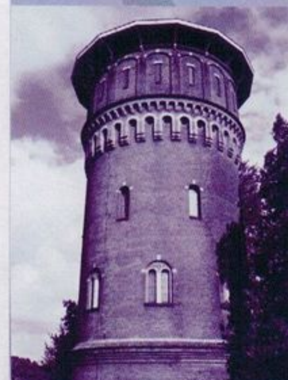
Parallelweg 127 "Watertoren". Ronde, bakstenen watertoren met 16-zijdig tentdak met een groot overstek.
