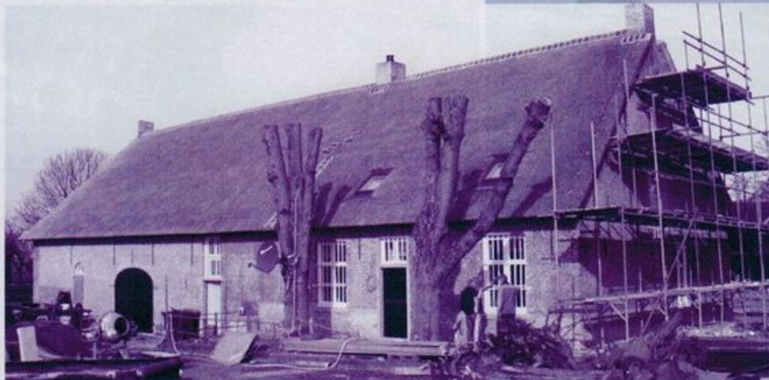
Restauratie boerderij Hildernisse in uitvoering
