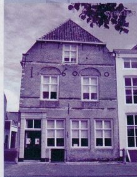
Croonenburch aan Noordzijde Haven. Onderkelderd hoekpand met een lijstgevel in schoon metselwerk.
